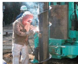
STEP 3 現場円周溶接
