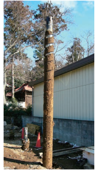
施工後に引き抜いた杭
