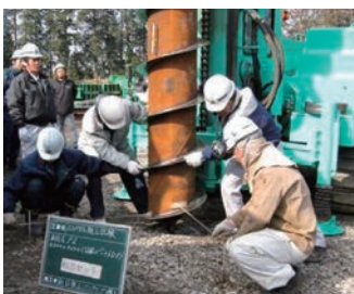
STEP 1 杭打ち機セット
