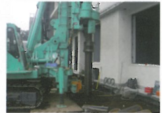
耐震補強工事
